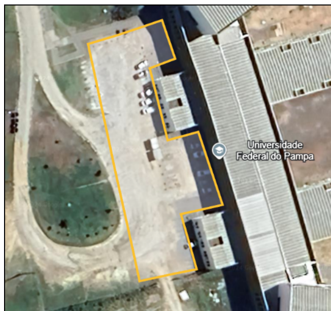
Figura 13 - Trecho de Pavimentação
