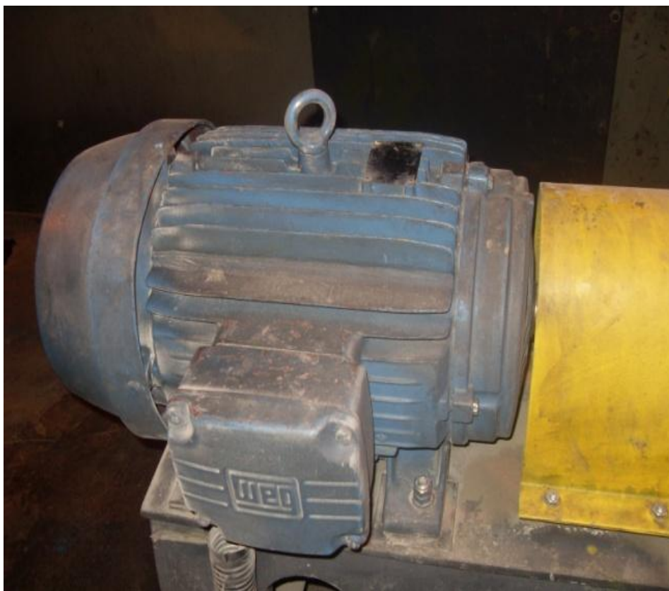
Figura 37-Foto do motor inspecionado (motor do ar secundário).
