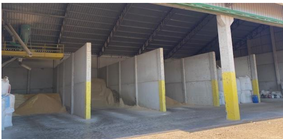
Figura 20 – Galpão de armazenamento dos insumos.
