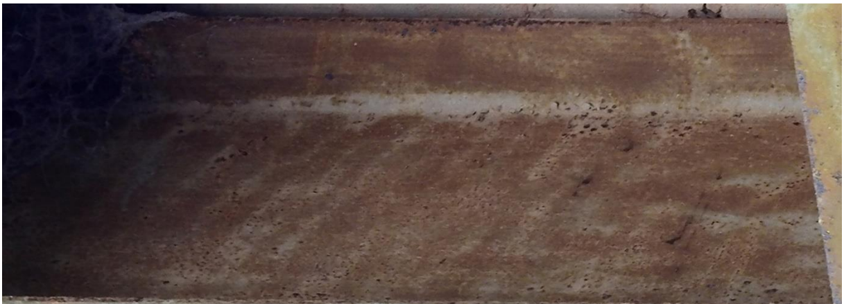
Figura 109 - T02VA - Corrosão alveolar e corrosão por pites
