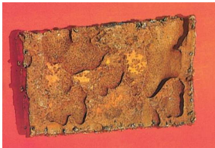
Figura 17 - Corrosão em placas
