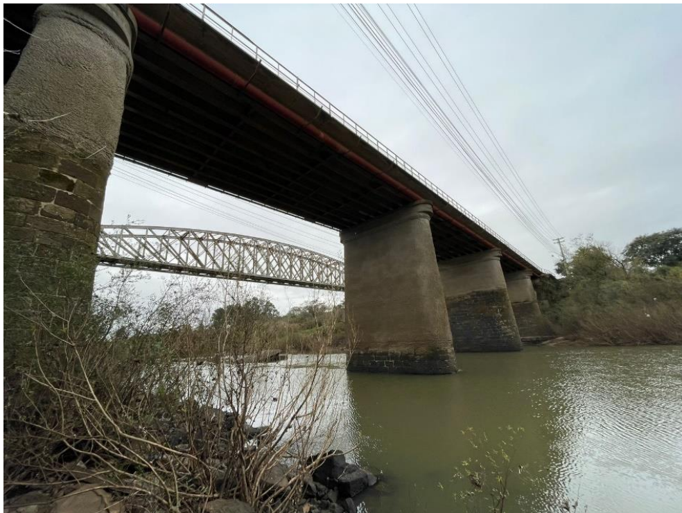
Figura 22 - Vista geral da Ponte Borges de Medeiros
