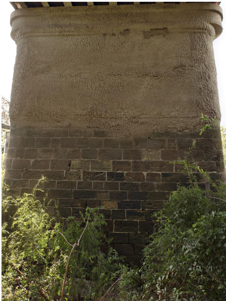
Figura 125 – Pilar em alvenaria com camada de reforço de argamassa armada
