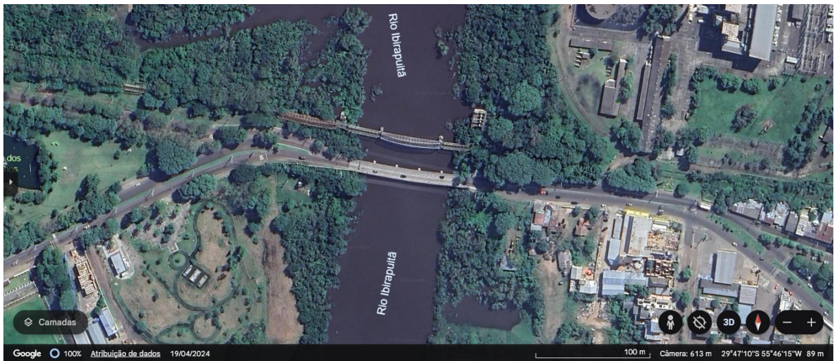
Figura 21 - Vista superior da Ponte Borges de Medeiros
