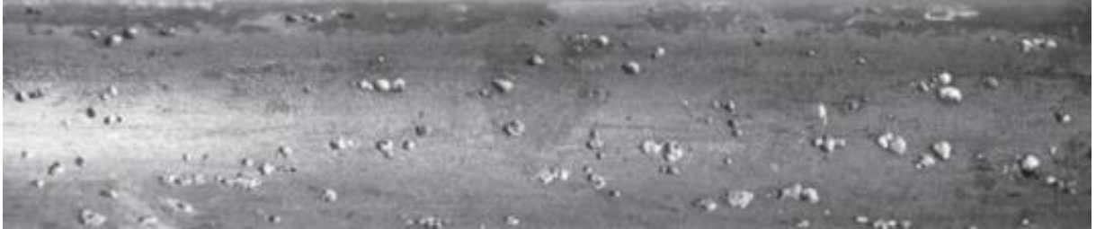
Figura 14 - Corrosão por pites
