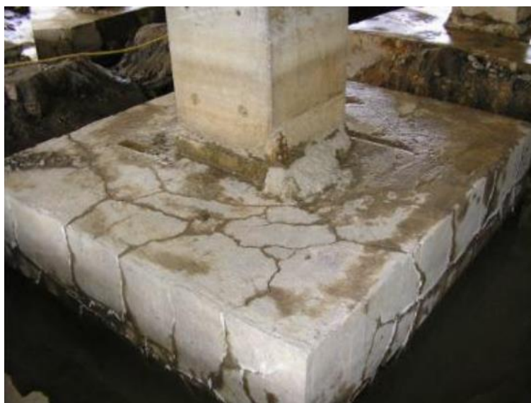
Figura 9 - Reação álcali agregado
