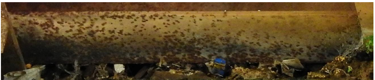
Figura 100 - T01AB - Corrosão alveolar
