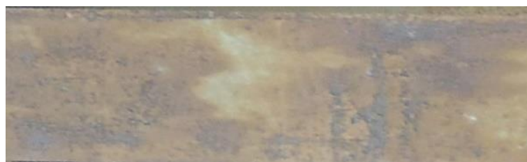
Figura 64 - L05 Jusante - Descascamento por corrosão
