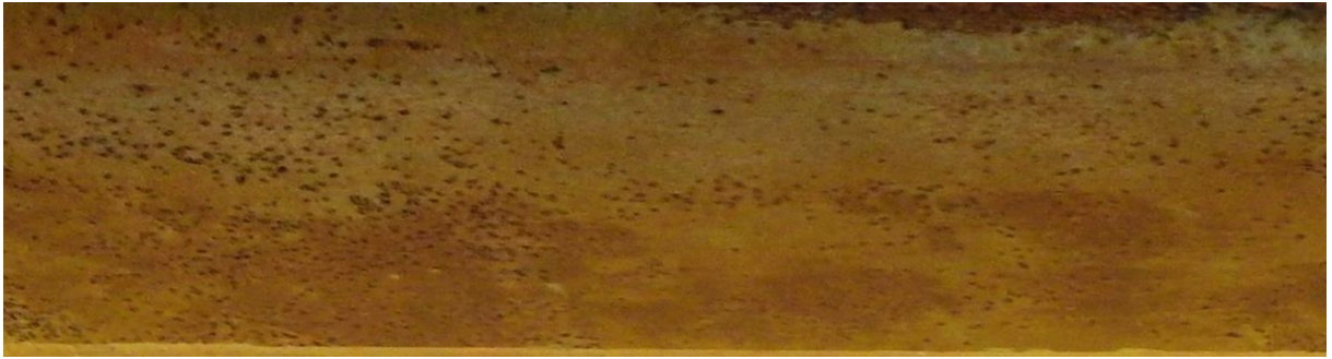
Figura 68 - L06 Montante - Corrosão por pites generalizada
