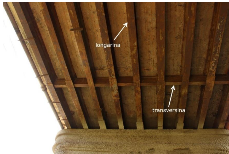
Figura 23 - Vista inferior do tabuleiro suportado por vigas longarinas e transversinas
