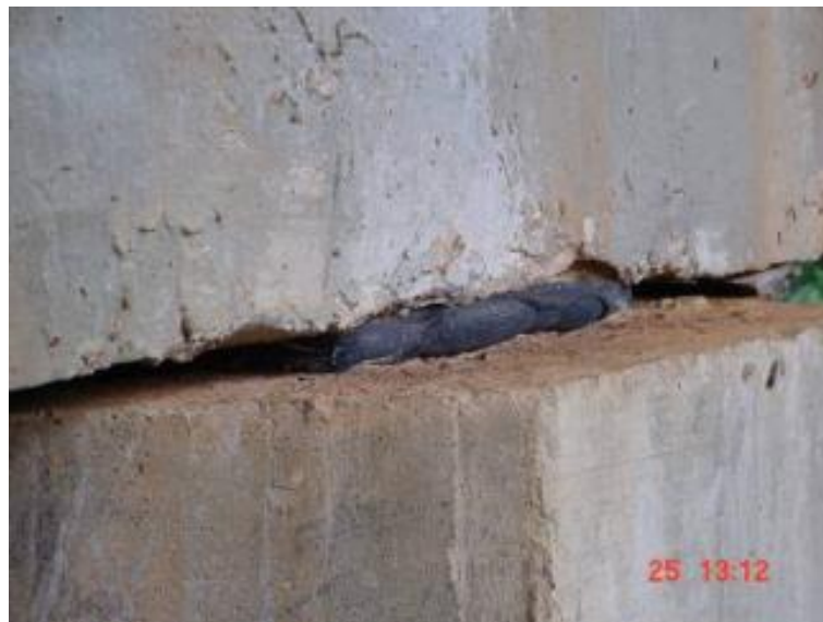
Figura 10 - Aparelho de apoio elastomérico esmagado
