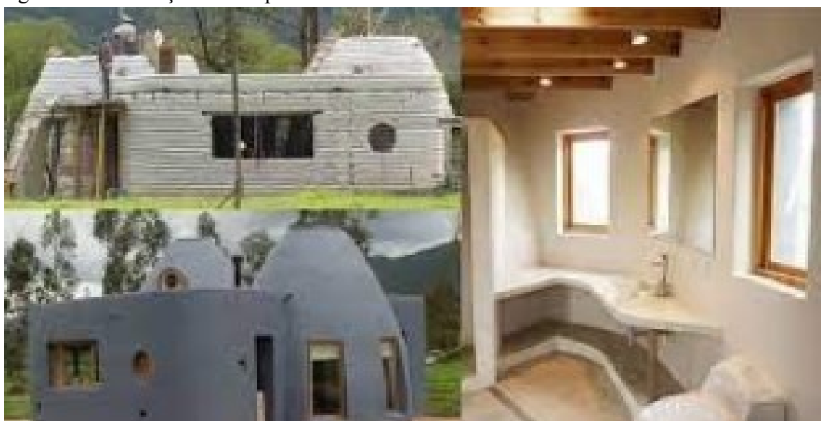
Figura 07: Construção com superadobe
