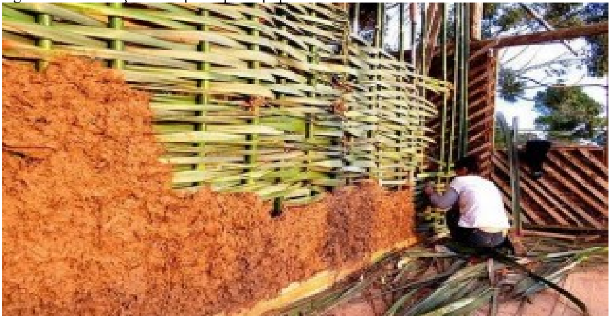
Figura 06: Construção de taipa ou pau a pique
