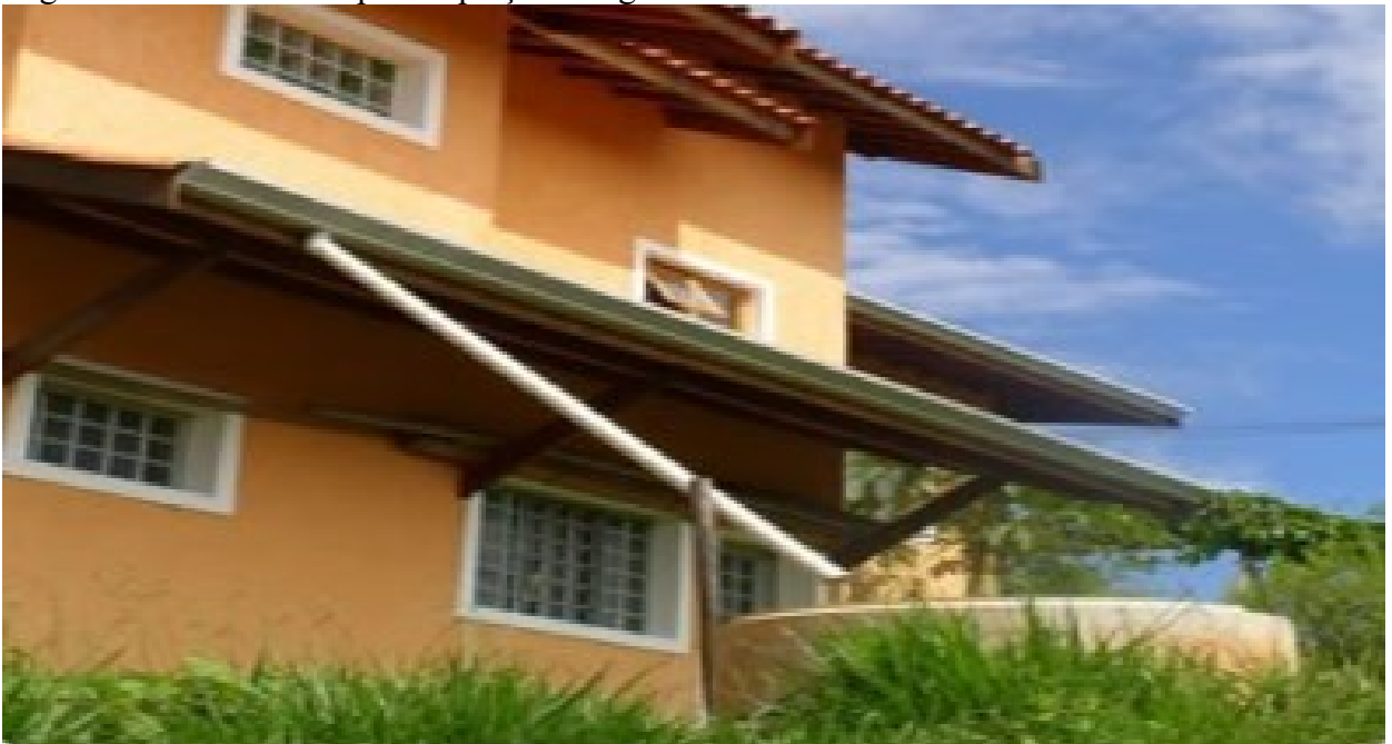
Figura 13: Reservatório para captação de água de chuva
