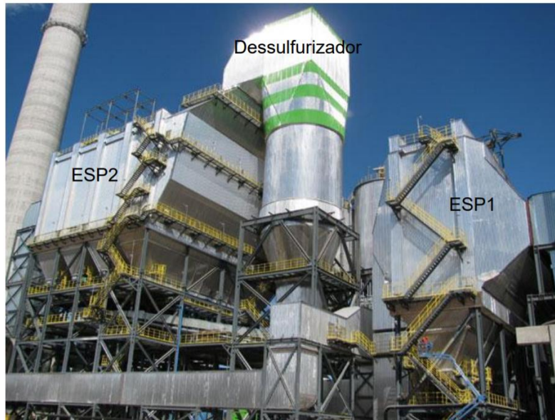
Figura 3 - Dessulfurizador e conjuntos de eletrofiltros
