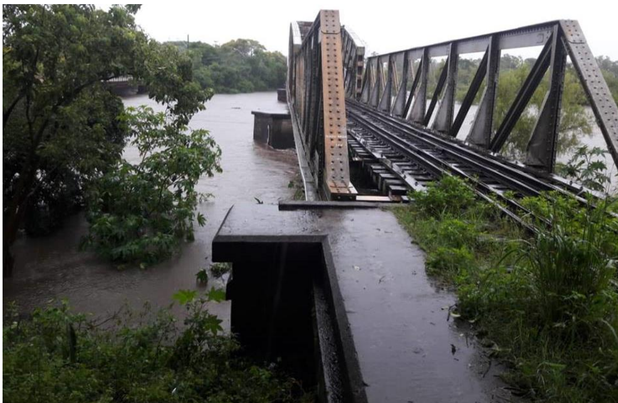
Figura 33 – Nível do rio sob a ponte ferroviária
