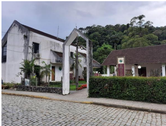
Figura 21 - Fachada da sede do PEPS.
