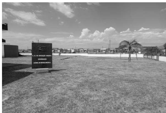
Figura 3 - Frente do prédio da escola, lado direito
