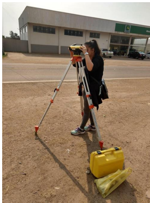
Figura 7: Execução do nivelamento
