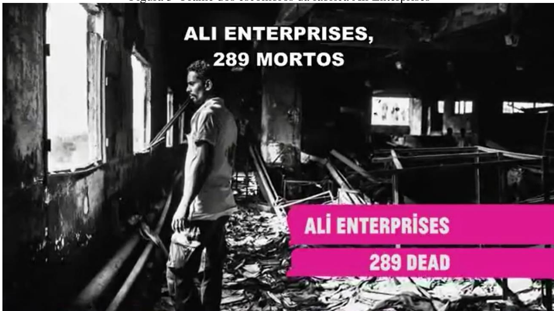
Figura 3- Frame dos escombros da fábrica Ali Enterprises
