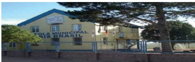
Figura 1 – Prédio da Escola Municipal de Ensino Fundamental Assis Brasil
