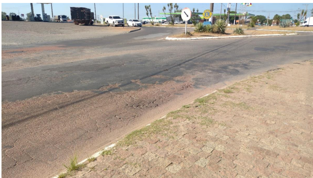
Figura 15 – Trevo de acesso a cidade
