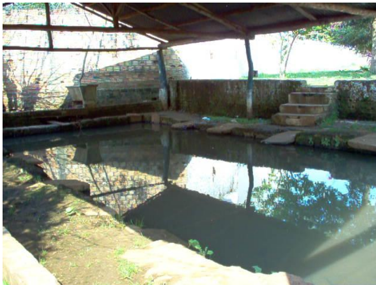
Figura 22: Imagem da fonte antes da revitalização
