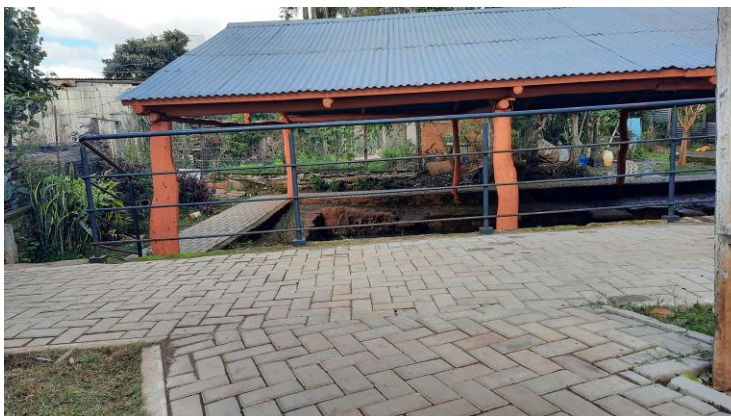
Figura 25: Proteção de ferro no entorno da fonte
