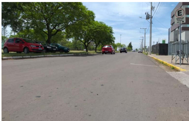
Figura 9 – Condições atuais da Avenida Tiaraju
