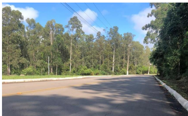
Figura 15 – Condições atuais da Trecho 1 de Santa Maria
