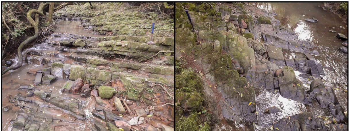
Figura 39 – Padrão de fraturamento NW bem marcado e paralelo à drenagem.
