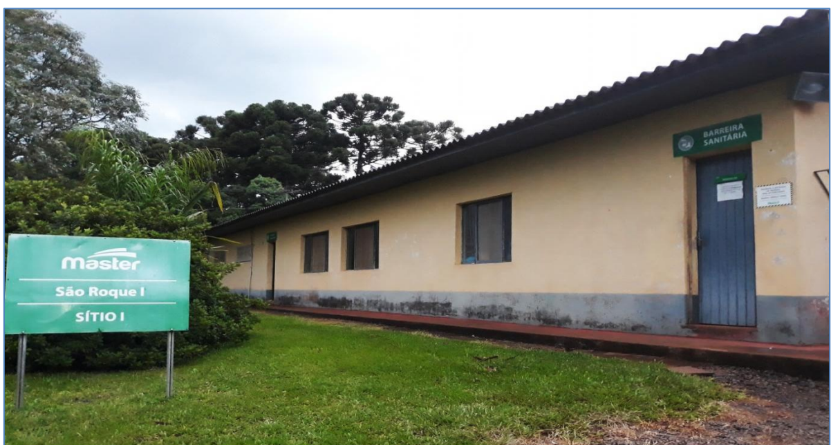
FIGURA 5 - Entrada da barreira sanitária São Roque I. Fonte: Arquivo pessoal.
