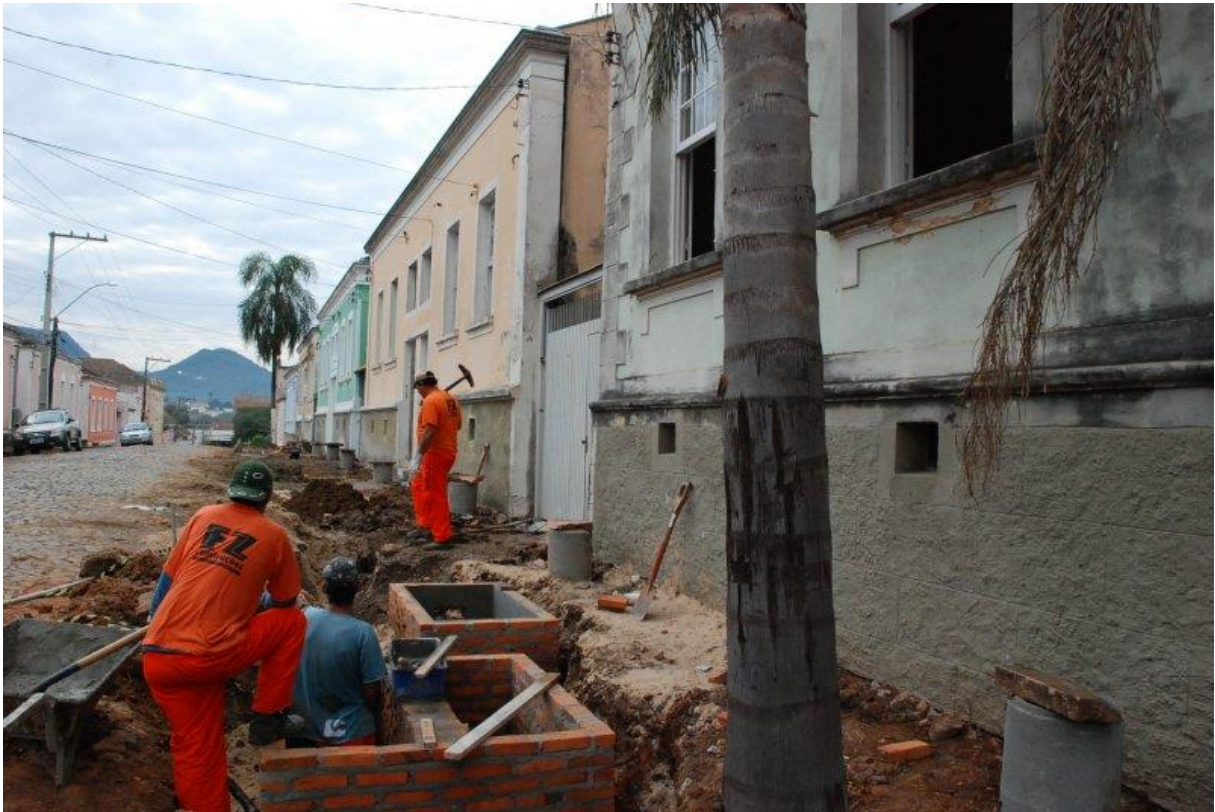
Figura 9 – Obras de revitalização da Vila Belga
