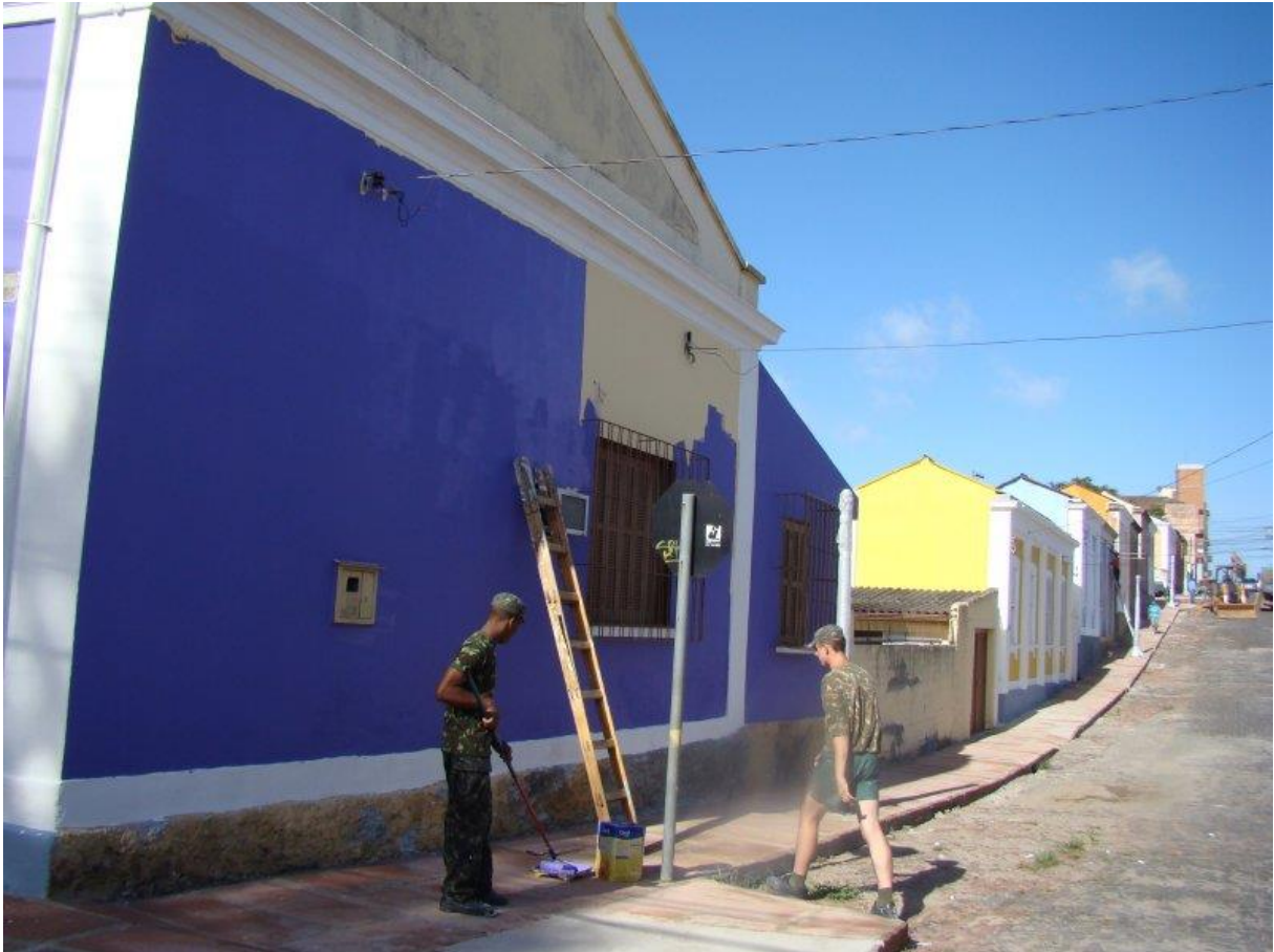
Figura 10 – Obras de revitalização da Vila Belga
