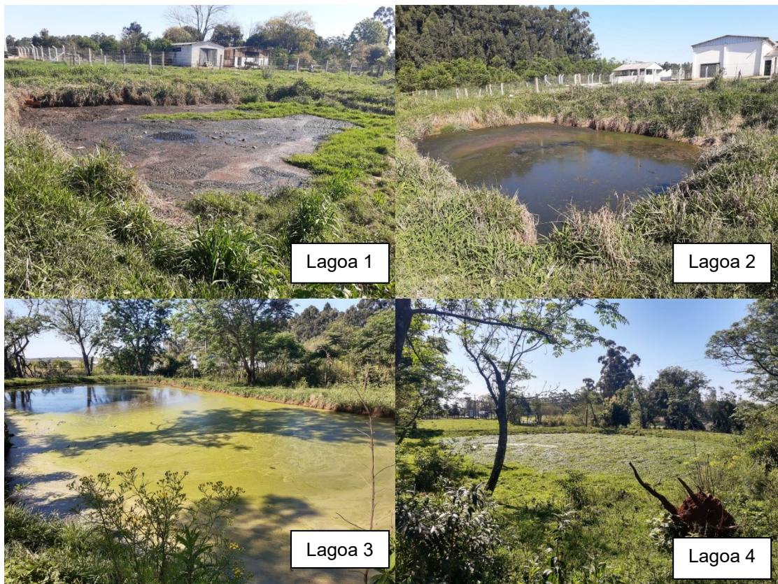
Figura 5 - Estação de Tratamento de Efluentes
