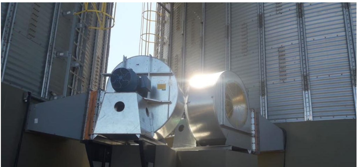
Figura 13 - Ventiladores de aeração para silos de armazenagem.
