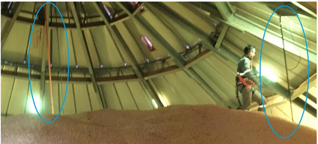
Figura 12 - Pêndulos de termometria instalados em silo de armazenagem.
