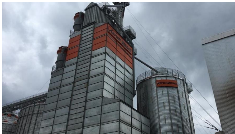
Figura 10 - Secador de cereais.
