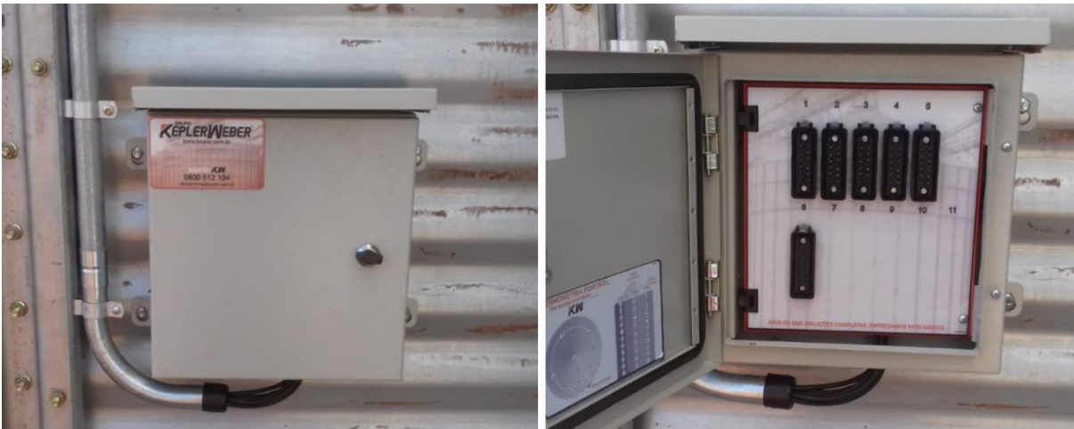
Figura 15 - Painel de conexão dos cabos de termometria.
