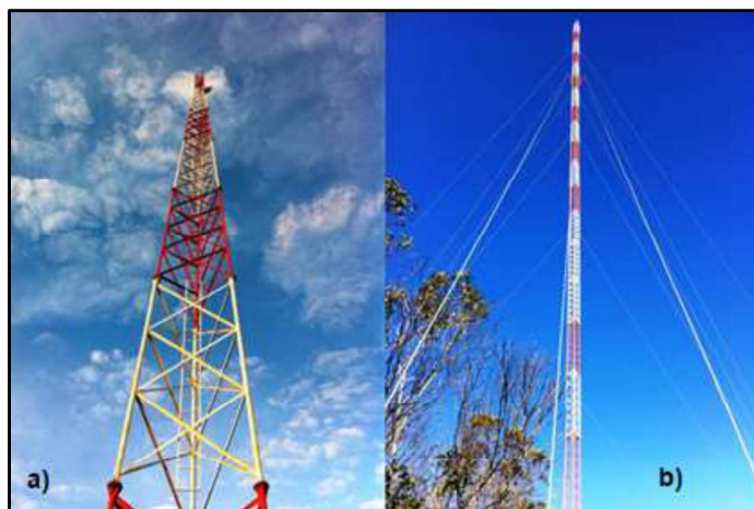
Figura 7 - Torre em treliça a) Torre autoportante e b) Torre estaiada.
