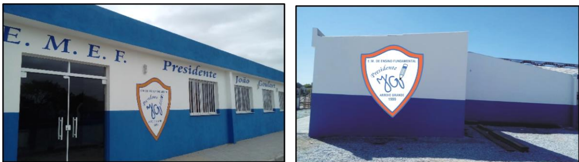
Figura 3 - Fotos do novo prédio da escola 8
