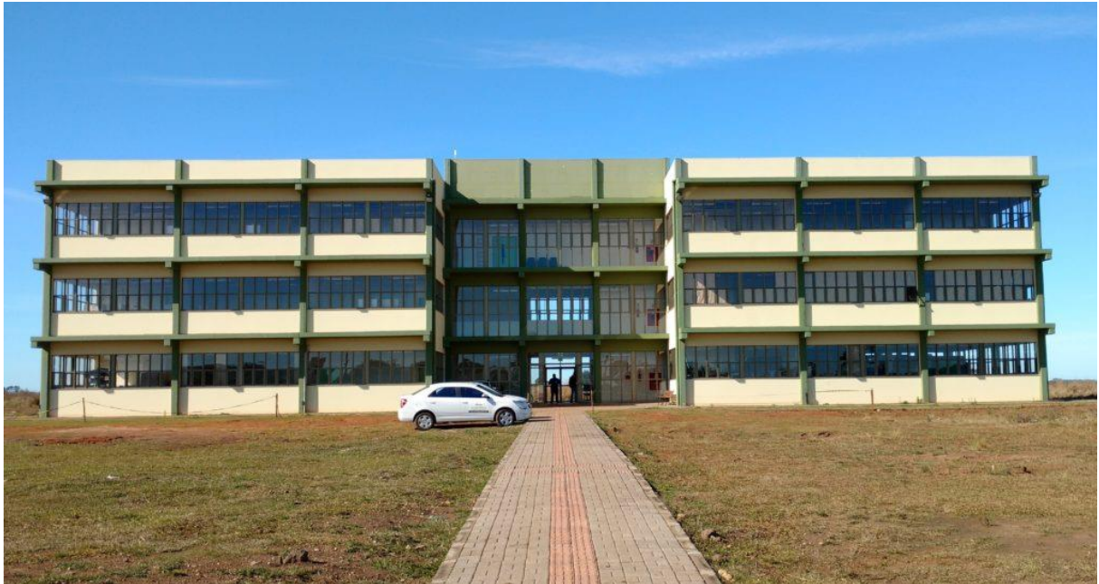
Imagem 3 – Universidade Federal do Pampa – UNIPAMPA Campus II de São Borja-RS.
