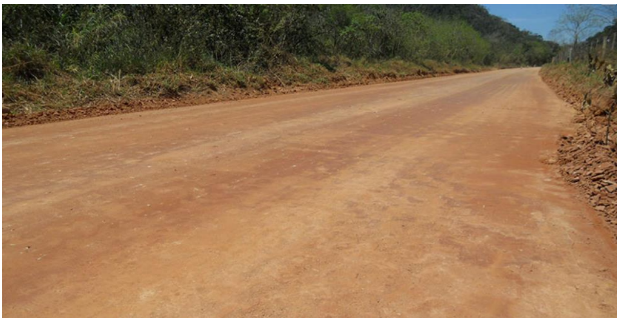
FIGURA 7 – Imagem de uma estrada já com o produto aplicado.
