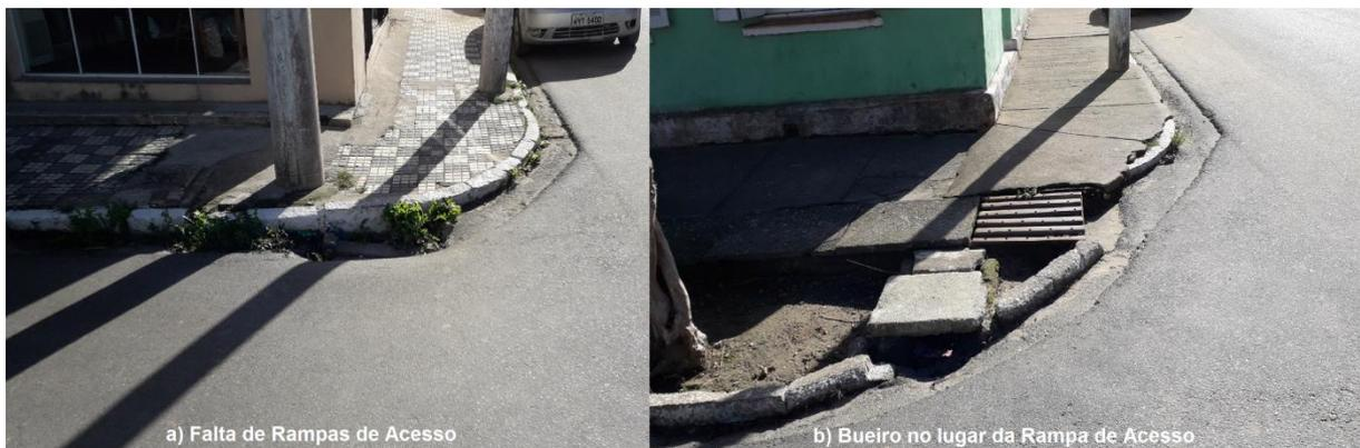
**Figura 14 Falta de Rampas, e Buracos na Rampa**
