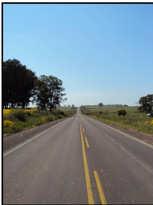
Figura 4 - Aspecto geral da BR 290 – trecho 427- 428 Km, São Gabriel/RS
