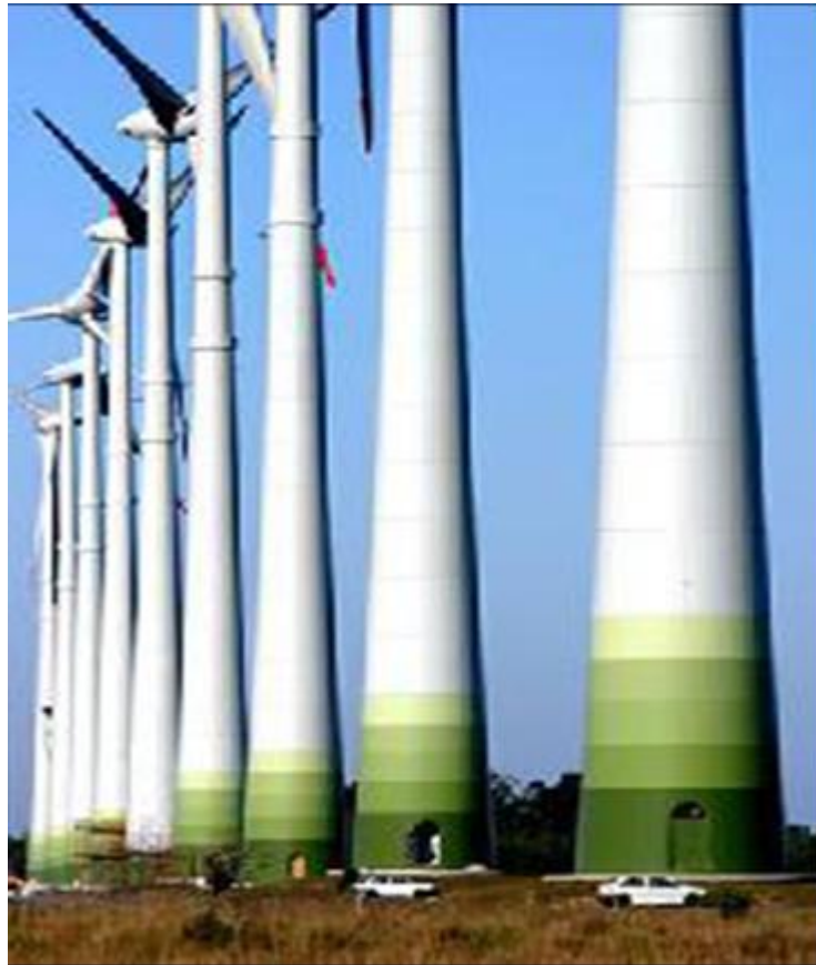
Figura 28 - Pintura das torres (Fonte: ENERFÍN, 2013)
