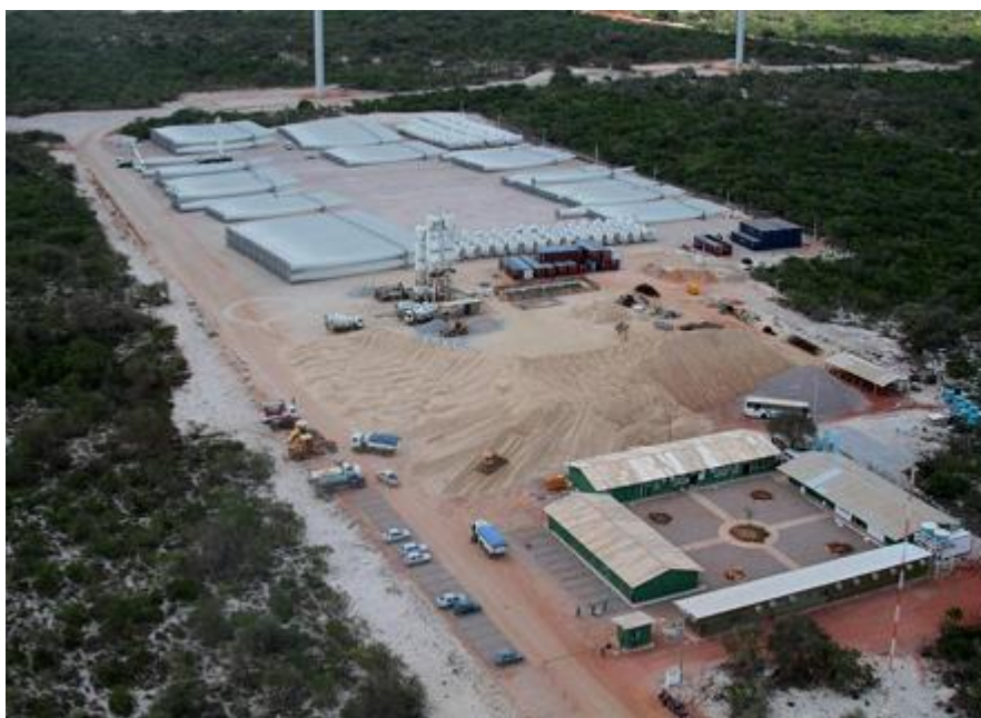
Figura 26 - Canteiro de Obras – Parque Eólico Alegria (Fonte: PIRES, 2011)
