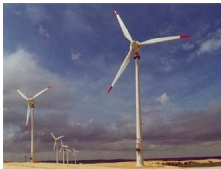
Figura 16 – Parque eólico conectado à rede – Parque Eólico da Prainha – CE (Fonte: CRESESB, 2014)
