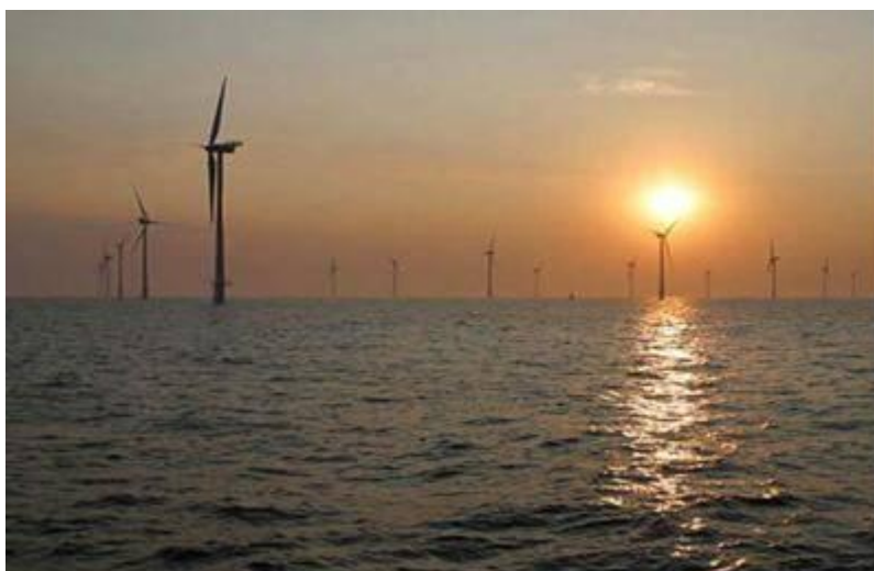
Figura 17 – Parque eólico instalado no mar do norte (Fonte: BRASIL ALEMANHA NEWS, 2010)
