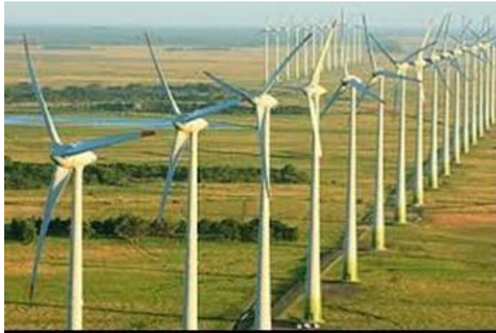
Figura 23- Parque Eólico de Osório – RS (Fonte: VENTOS DO SUL ENERGIA, 2014)
