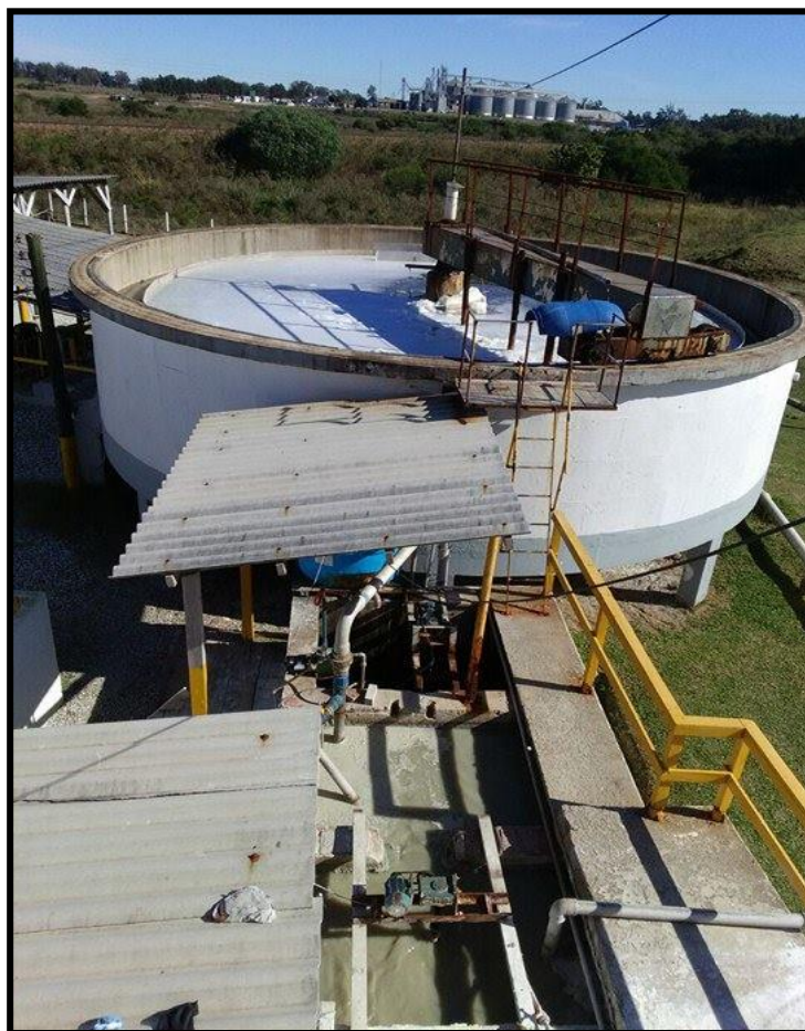
Figura 14- Clarificador (Sedimentador) e tratamento das Gerais.
