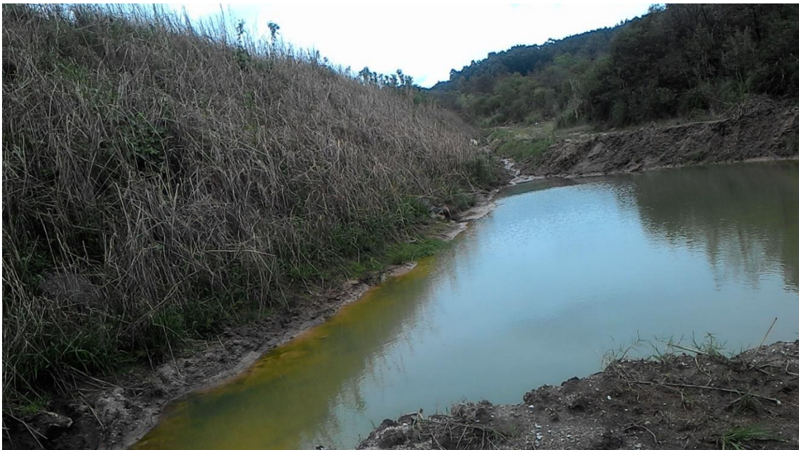
Figura 14 - Ponto de coleta P4- Bacia de decantação Fonte: O autor, 2018.
