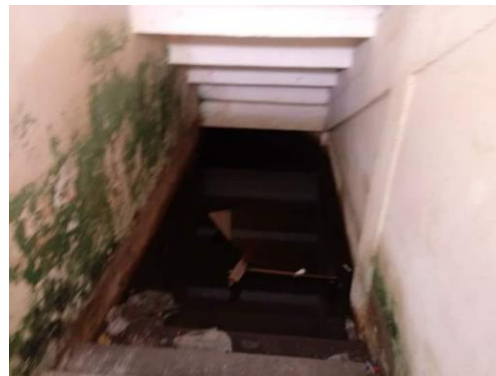
Figura 7: Túnel de acesso ao gramado
