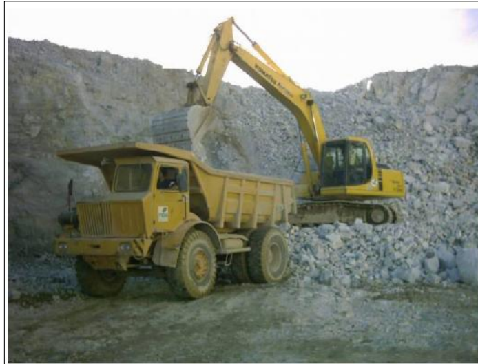
Figura 7: Caçamba e escavadeira.
