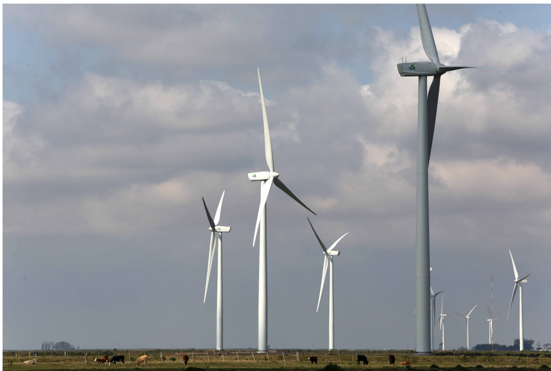
Figura 3.6: Turbinas eólicas de eixo horizontal no Complexo Eólico Campos Neutrais
