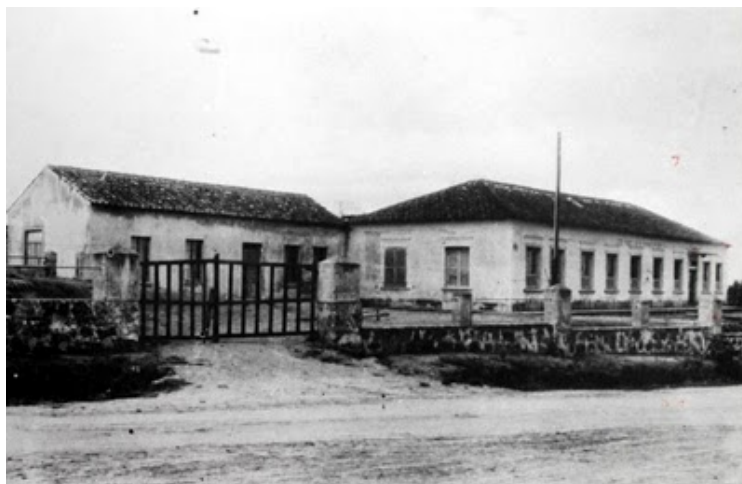
Primeiro prédio do colégio/1934
