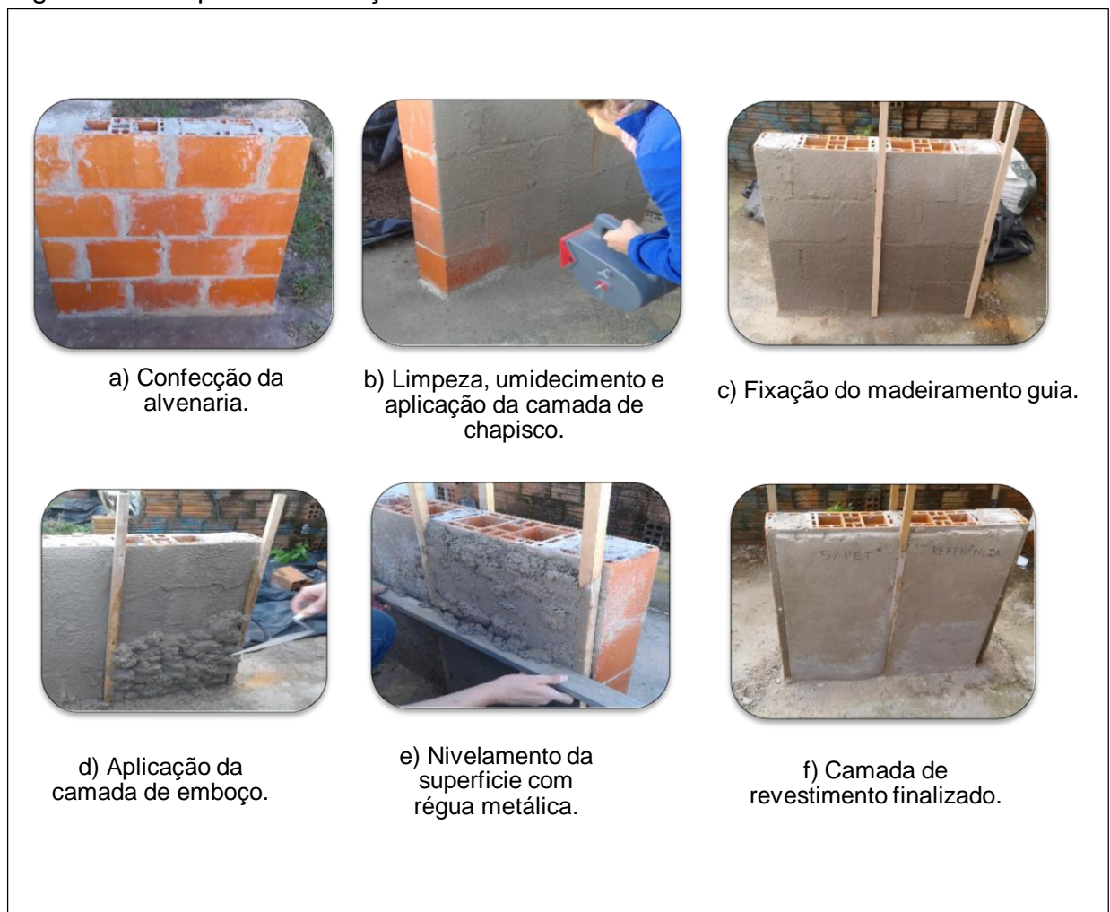
Figura 25 - Etapas de execução da alvenaria e revestimento
