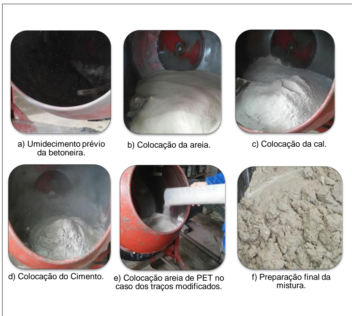
Figura 17 - Etapas de execução da produção das argamassas
