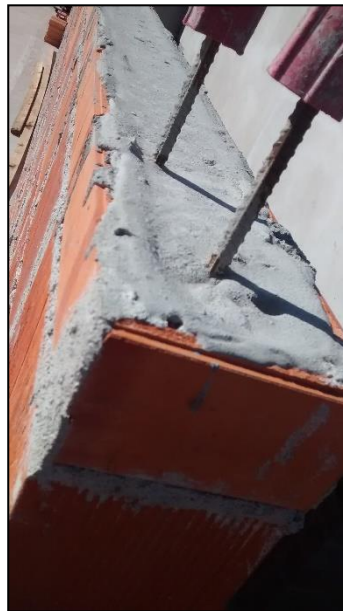
Figura 7 – Graute e armadura em parede estrutural
