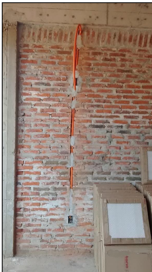
Figura 4 – Rasgo em parede para instalação de eletroduto
