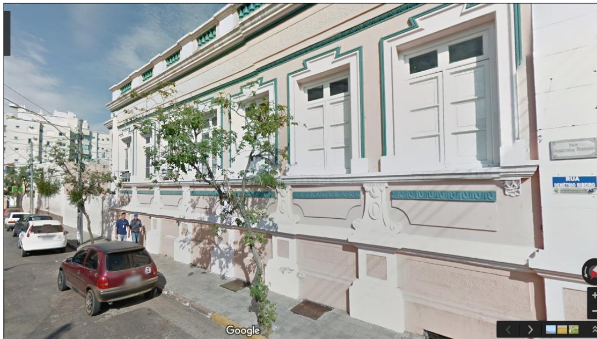
Figura 34 – Vista lateral da Prefeitura Municipal - rua Demétrio Ribeiro
