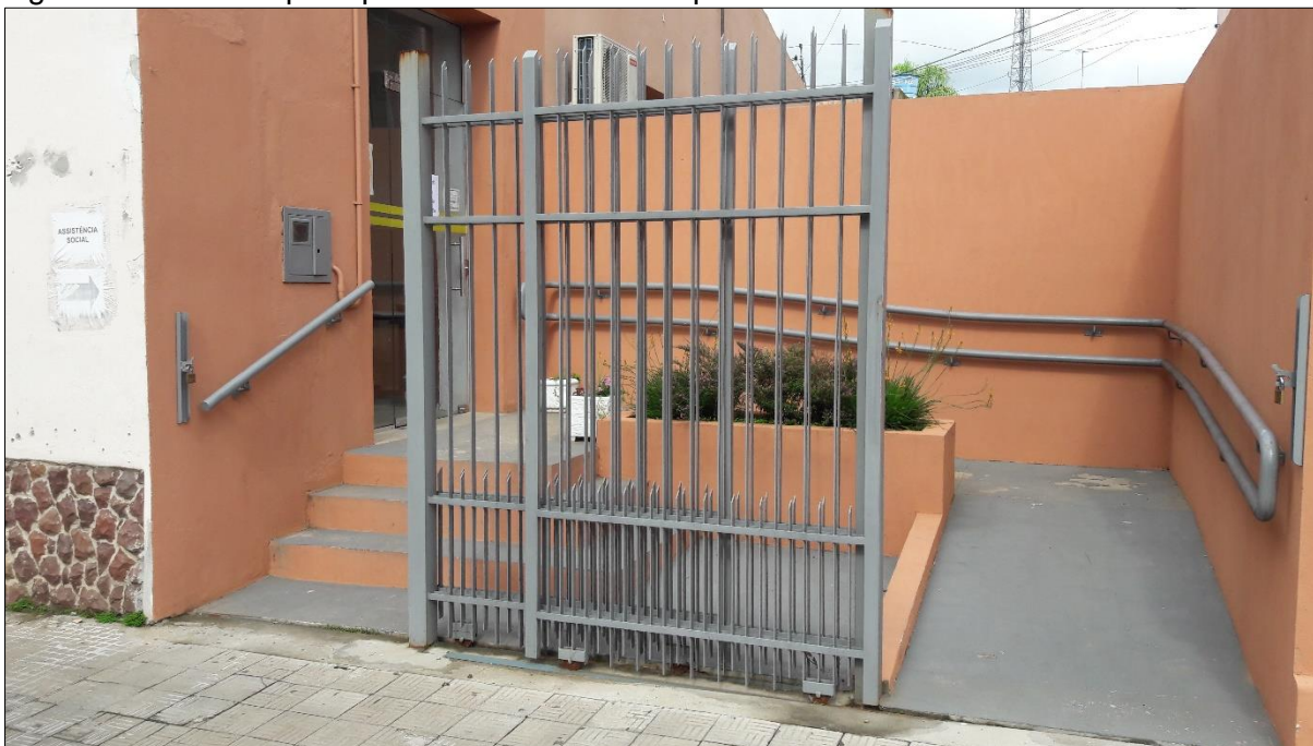
Figura 43 – Acesso principal com acessibilidade pela rua Demétrio Ribeiro
