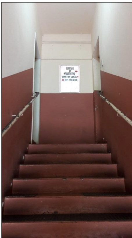
Figura 47 – Escada de acesso ao pavimento superior do bloco C da Secretaria de Infraestrutura
