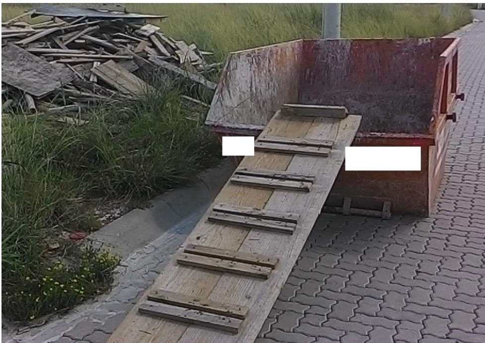
Figura 15 - Armazenamento dos resíduos fora do canteiro de obras
