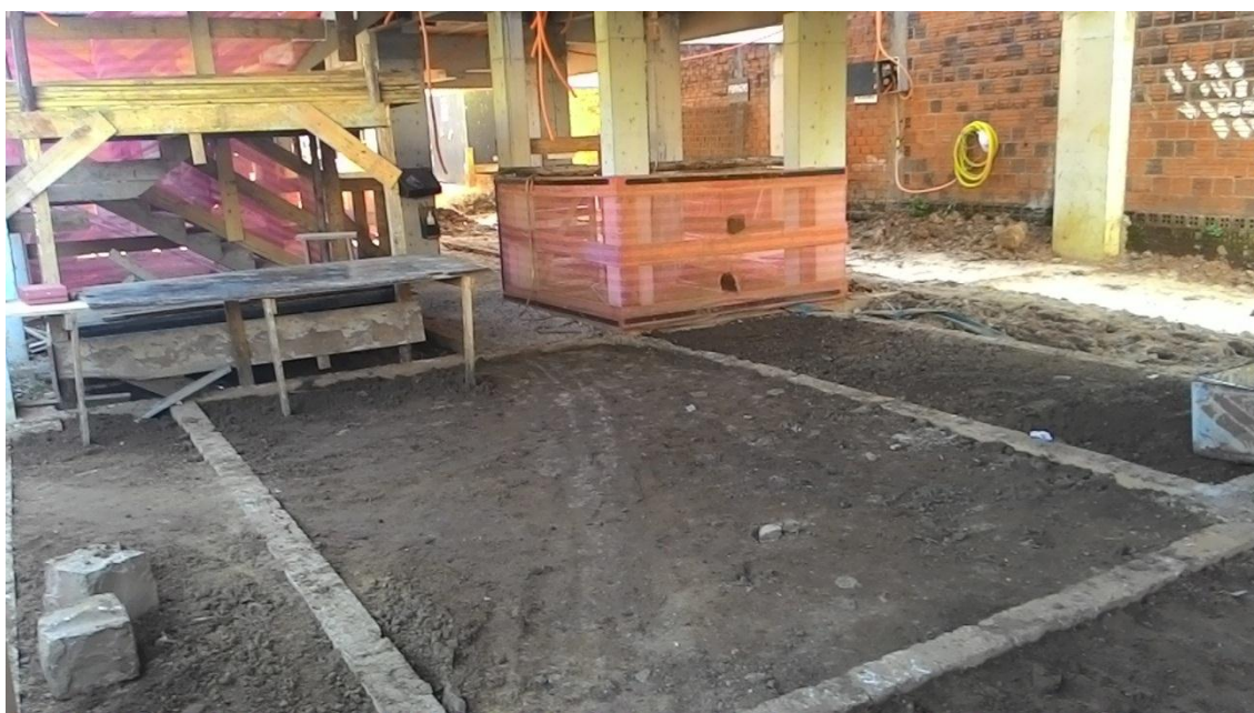
Figura 9 - Canteiro de obras
