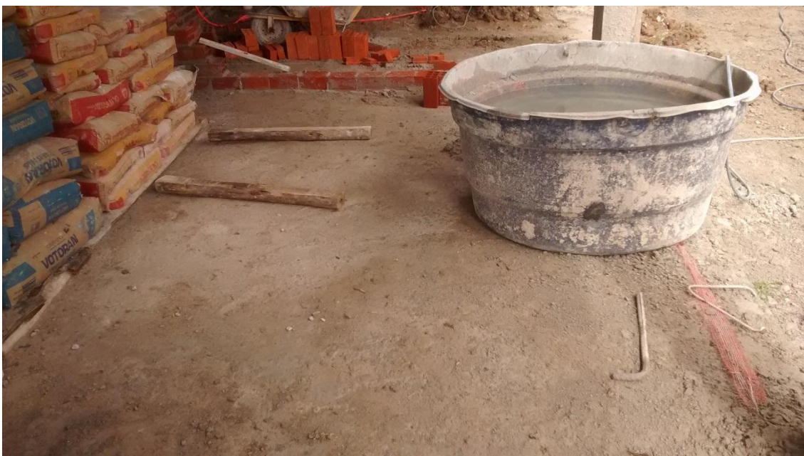
Figura 19 - Caixa d'água para utilização na betoneira
