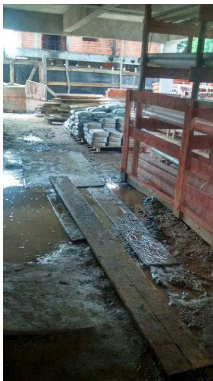
Figura 17 - Canteiro de obras bem organizado
