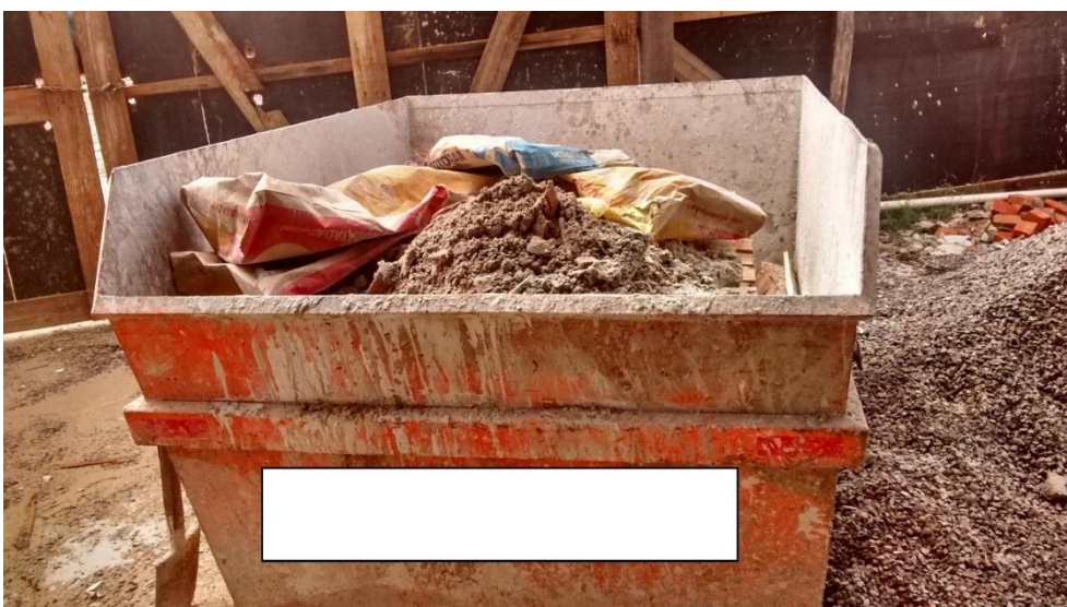
Figura 16 - Armazenamento dentro do canteiro de obras
