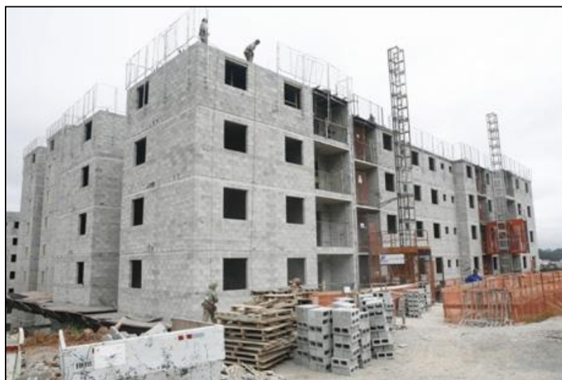
Figura 4 – Edificação em alvenaria estrutural
