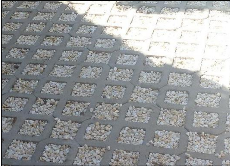
Figura 10 - Bloco vazado preenchido com brita
