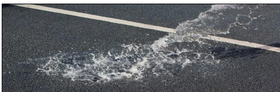
Figura 17 – Drenagem de CPA
