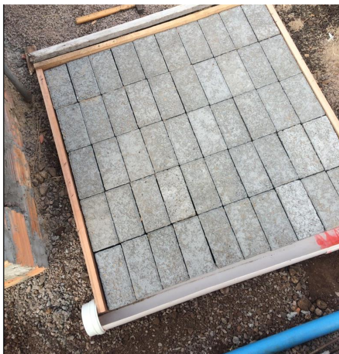
Figura 24 - Blocos assentados para execução do ensaio
