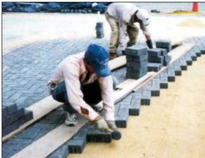
Figura 15 – Colocação de blocos intertravados de concreto
