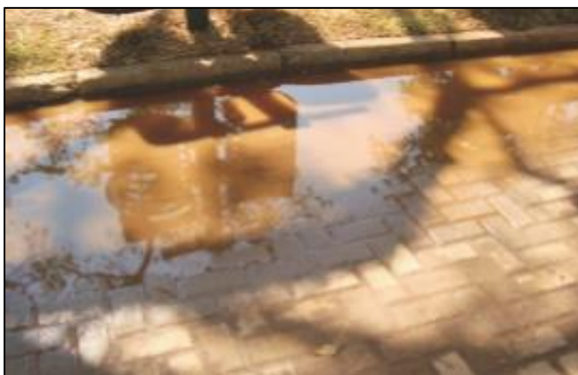
Figura 18 – Colmatação de pavimento permeável
