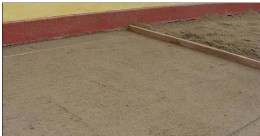
Figura 14 – Execução de camada de assentamento
