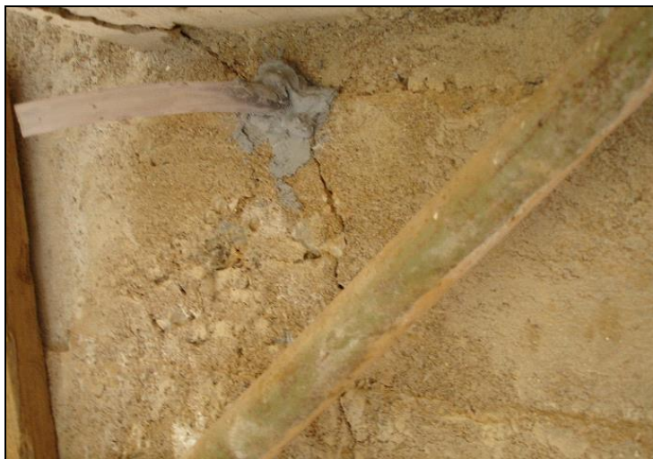
Figura 8 - Execução de injeção de resina epóxi nas fissuras
