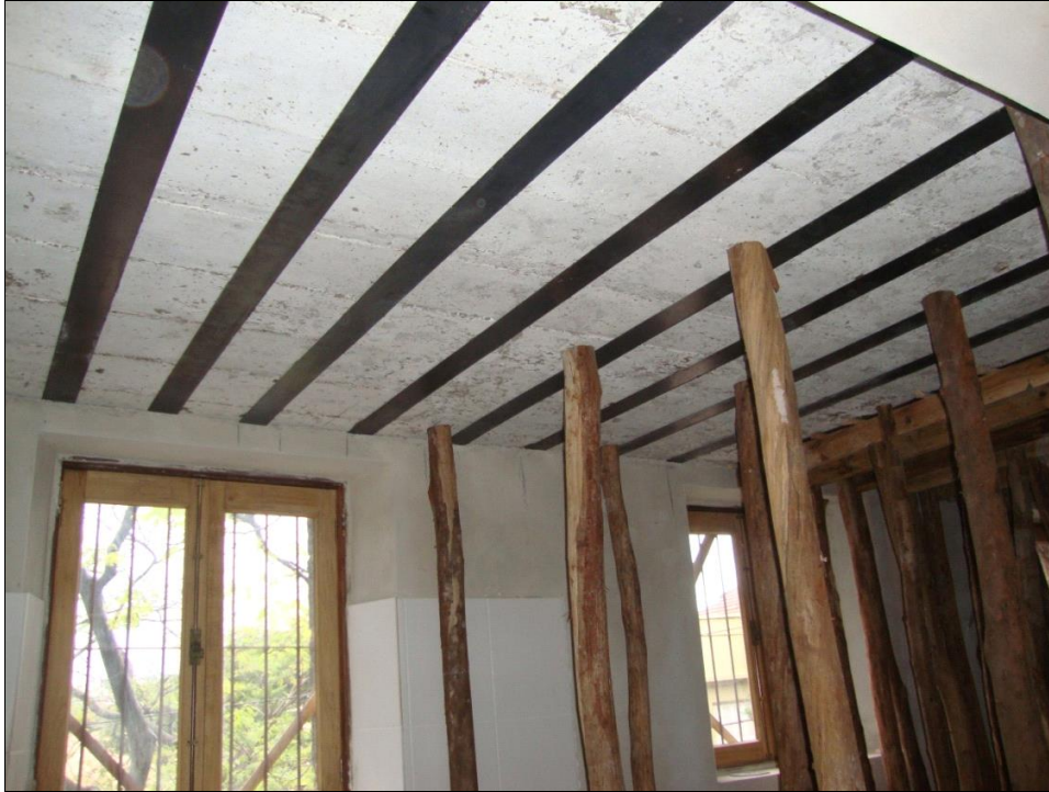
Figura 7 - Reforço de laje em concreto armado com o uso de chapa metálica colada
