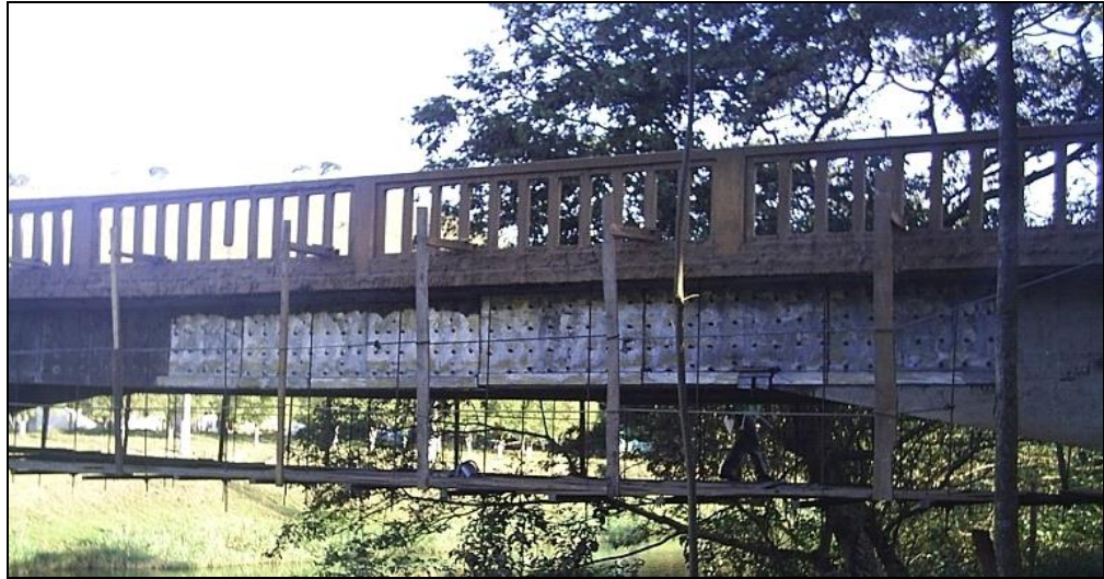
Figura 11 - Reforço por adição de chapas metálicas
