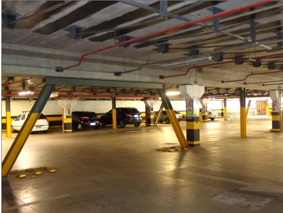
Figura 3 - Reforço à flexão com o uso de fibra de carbono e proteção externa em laje de concreto armado
