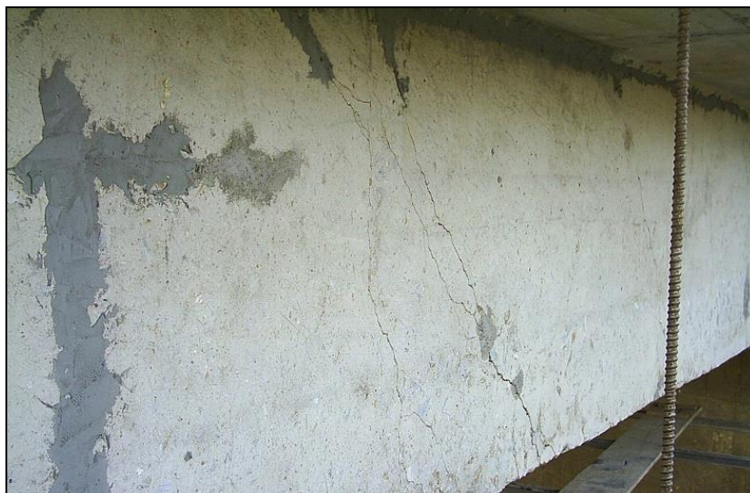
Figura 9 - Substrato de concreto selado
