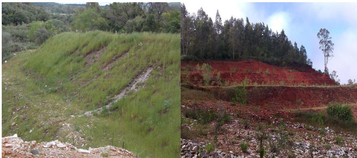
*Figura 7. Parte oeste reflorestada (esquerda) e Taludes reconfigurados (direita).*
