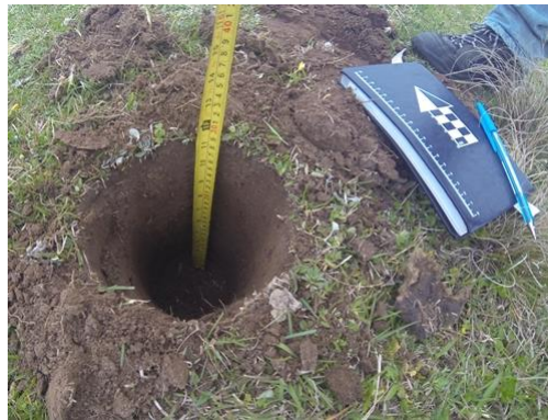
Figura 18 – Sondagem com cavadeira manual, profundidade de 0,30 m na sondagem 8.
