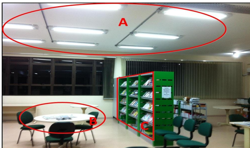
Figura 1: Detalhe sistema atual de iluminação- Campus Jaguarão.
