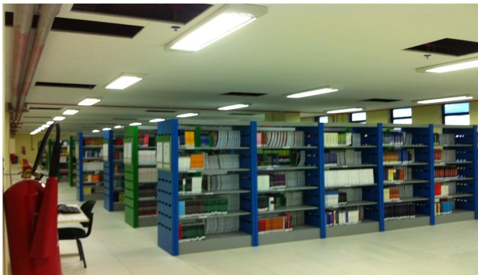
Figura 27: Vista da biblioteca- sistema atual iluminação- Bagé.
