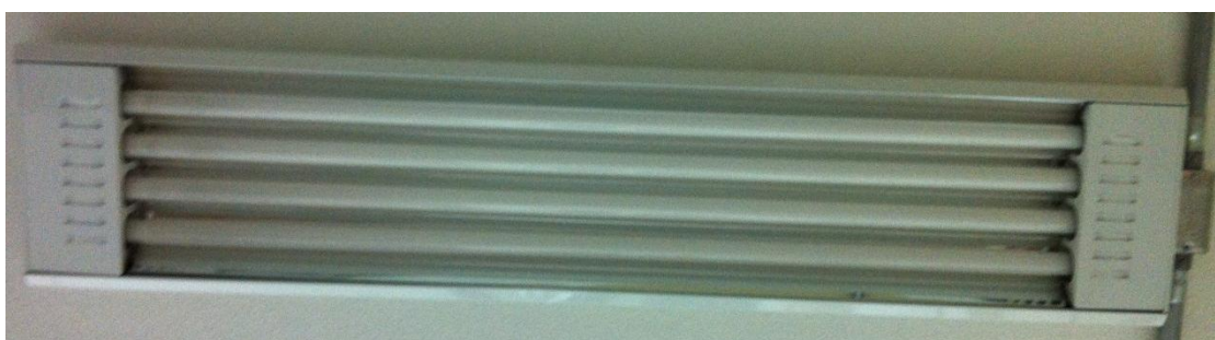
Figura 84: Luminária atual – 4x32W instaladas nas salas de aula.
