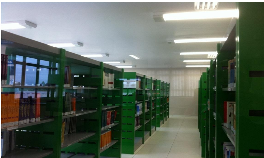
Figura 28: Vista sistema atual iluminação- Biblioteca Dom Pedrito.
