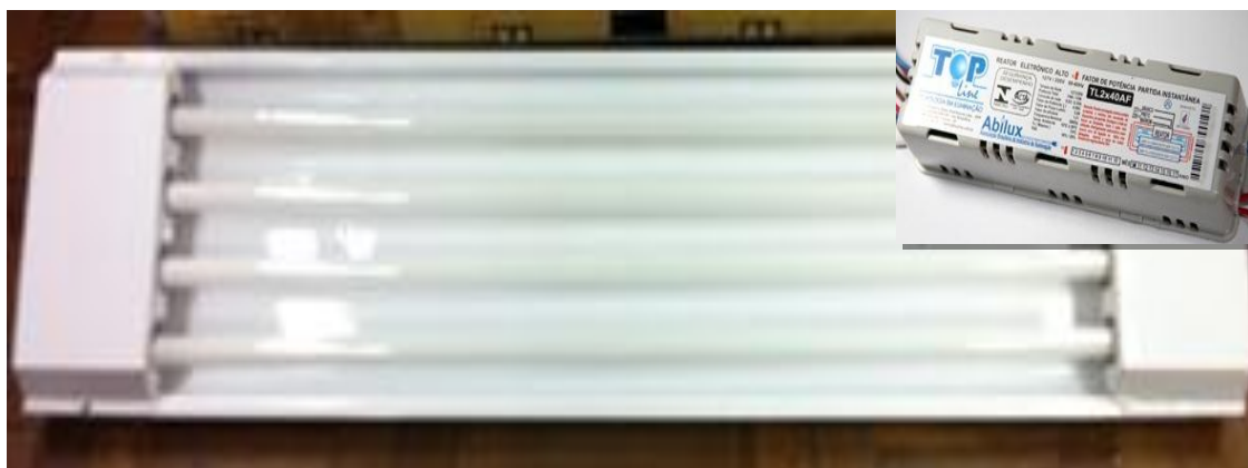
Figura 25: Luminária do sistema atual de iluminação, 4x32W.
