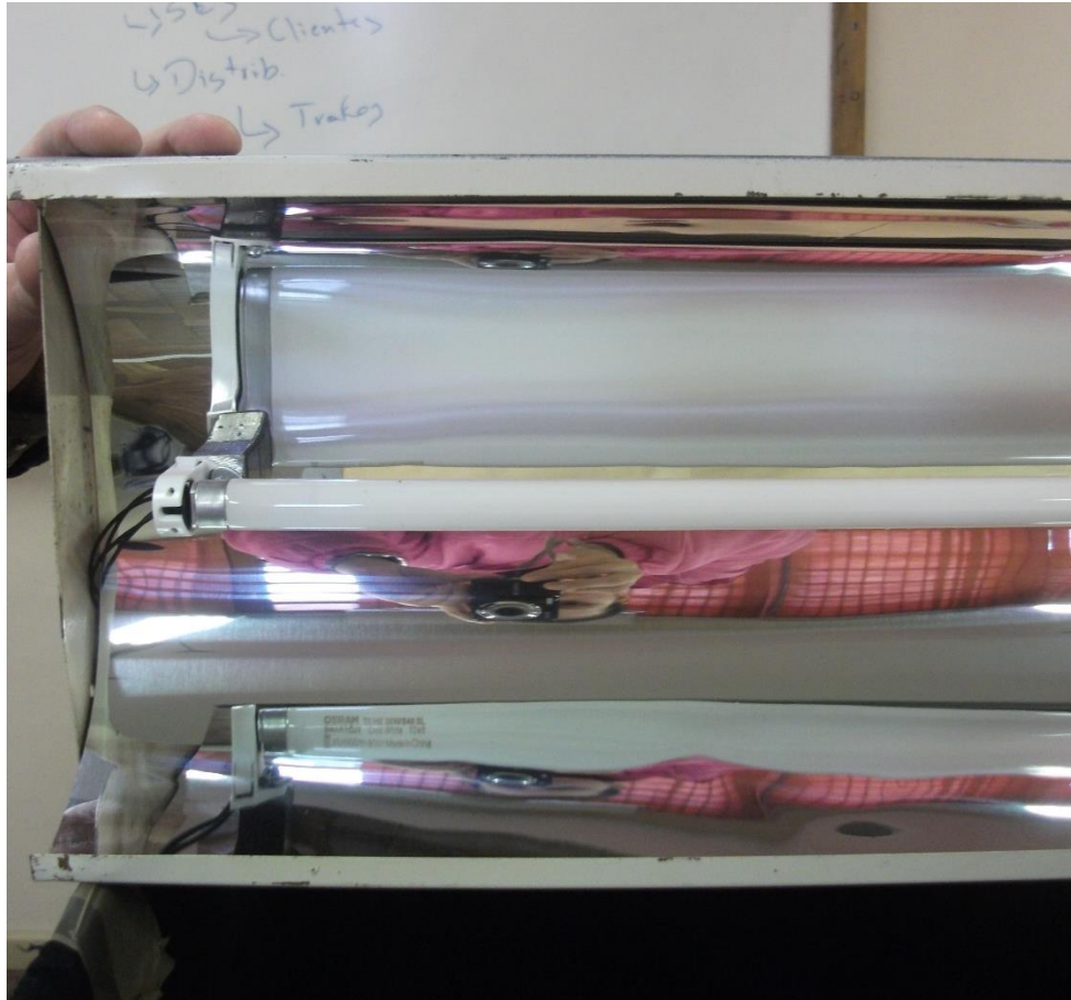
Fig. 3.21. Adaptação da Luminária com refletor para calha existente
