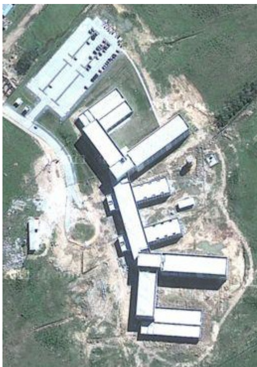
Figura 02: Instalações da UNIPAMPA Campus Bagé (RS).
