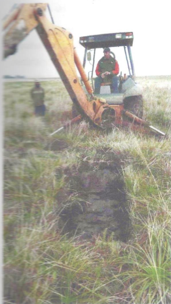
Figura 1 - Fotos da abertura da trincheira e identificação do perfil de solo no eixo da barragem
