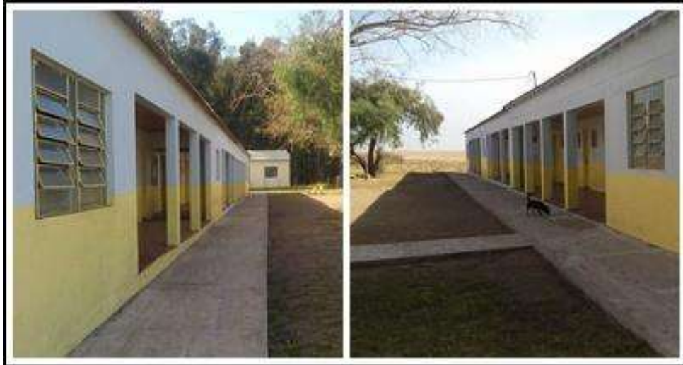
Figura 6 – Escola Municipal Rural Sucessão dos Moraes
