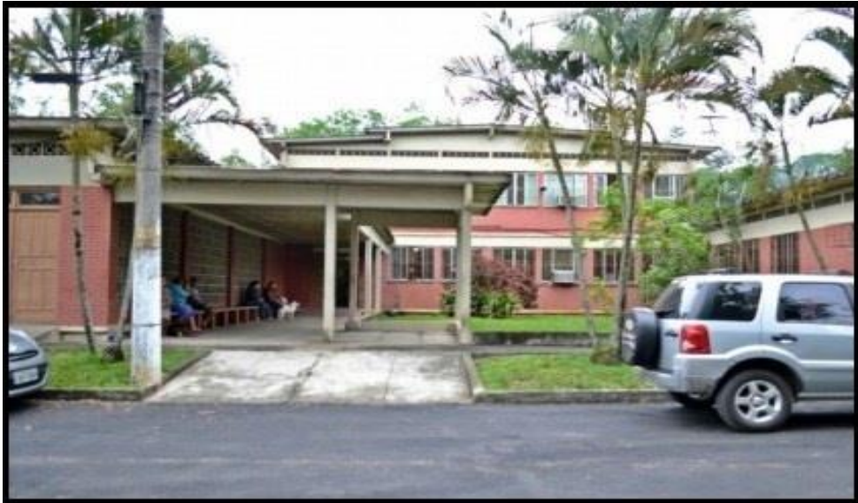
FIGURA 1- Fachada do Hospital Veterinário de Pequenos Animais da UFFRJ.
