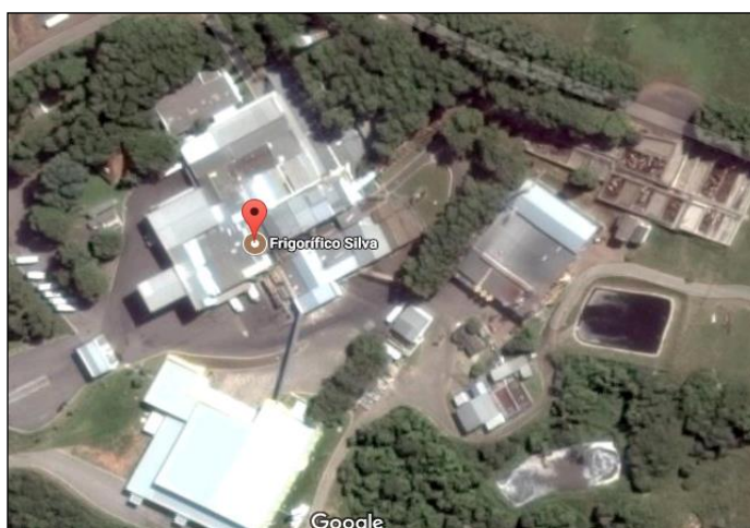
FIGURA 1- Vista aérea do Frigorífico Silva. Fonte: google maps.
