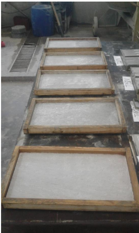
Figura 12 – Moldes acoplados no substrato para garantir a espessura da argamassa
