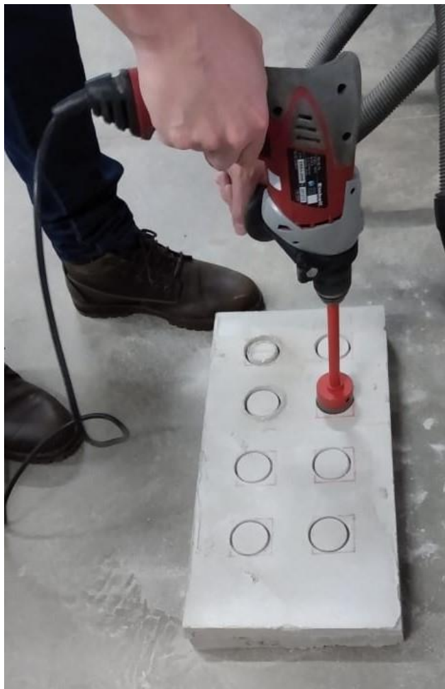
Figura 20 - Perfuração da argamassa com a serra copo
